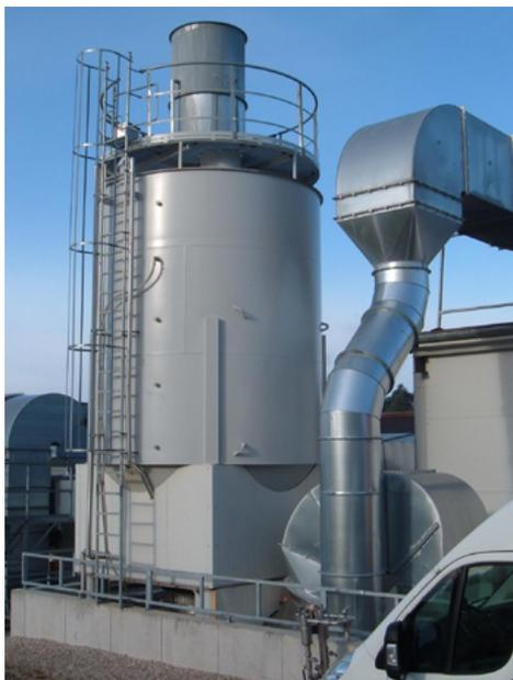
**Abbildung 33: Biorieselbettreaktor der Firma IDS Miesbach GmbH zum biologischen Abbau von flüchtigen Kohlenwasserstoffen aus Lackieranlagen, Foto: Gredmaier/Grüner-Lempart**
